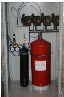
Преимущества модульных установок пожаротушения **BONPET** - это высочайшая надежность всей системы, простота проектирования, монтажа и дальнейшего обслуживания. Комбинированный, объемно-поверхностный способ тушения пожаров, позволяет быстро ликвидировать горение практически всех веществ, за исключением веществ, реагирующих с водой с выделением горючих газов и тепловой энергии, при минимальной затрате огнетушащего вещества и его максимальной эффективности.
